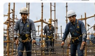
建設業（型枠工事・鉄筋）
